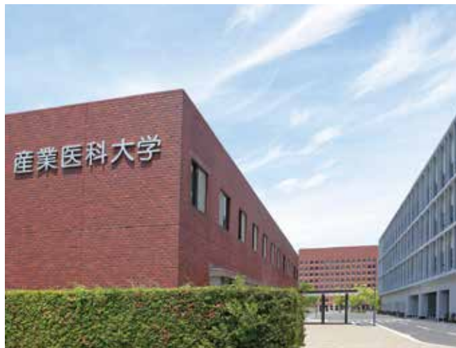
事務局本部 Administration Bureau Building
