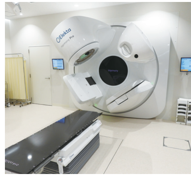
南別館/リニアック室 South Annex/Linac Room
