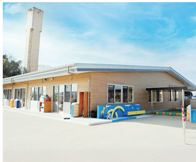
ラマティー保育園 Ramatti Nursery School
