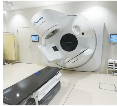
南別館/リニアック室 South Annex/Linac Room
