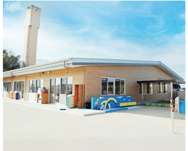
ラマティー保育園 Ramatti Nursery School
